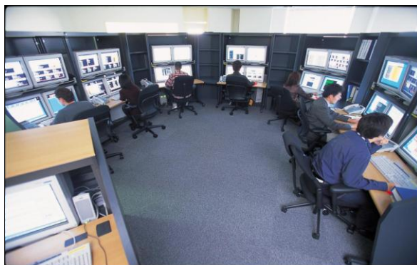
【サイトロック オペレーションセンター】
